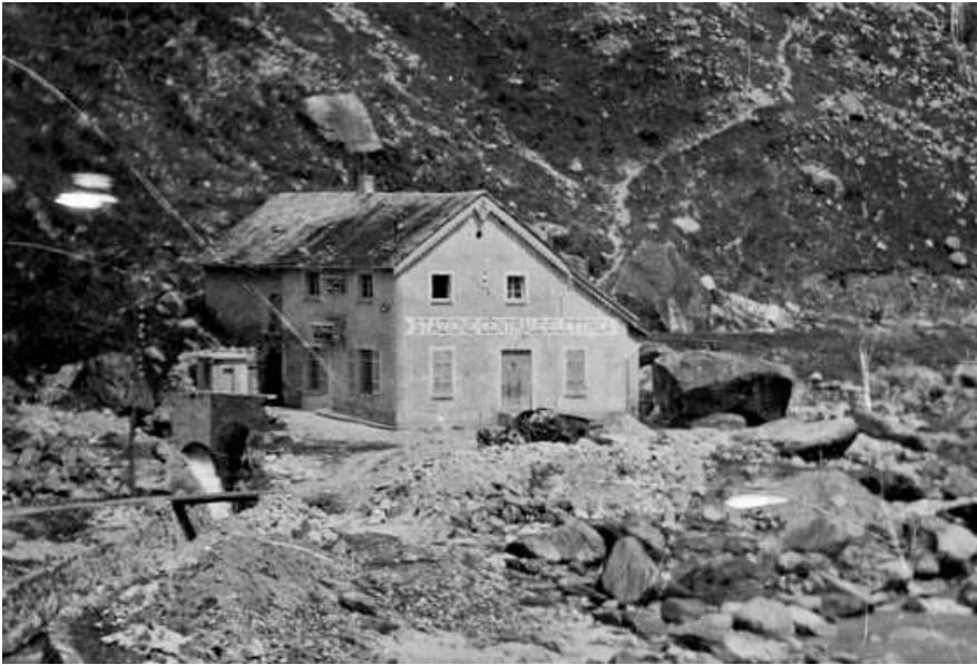
La "Stazione centrale elettrica" di Biasca a Loderio (da www.museodellamemoria.ch )
